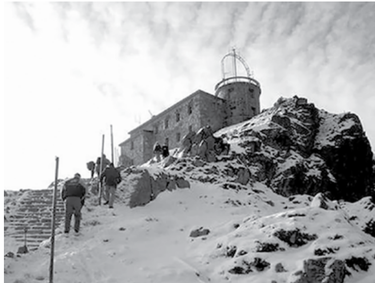
Szczyt Kasprowego. Budynek Obserwatorium
