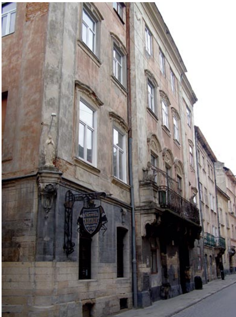
Budynek przy ul. Ormiańskiej 13 we Lwowie, w którym mieściło się Muzeum Ormiańskie
